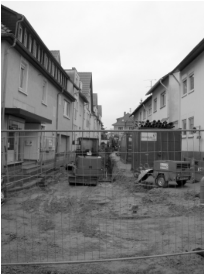
Baustelle in der Geheimrat-Schott-Straße
